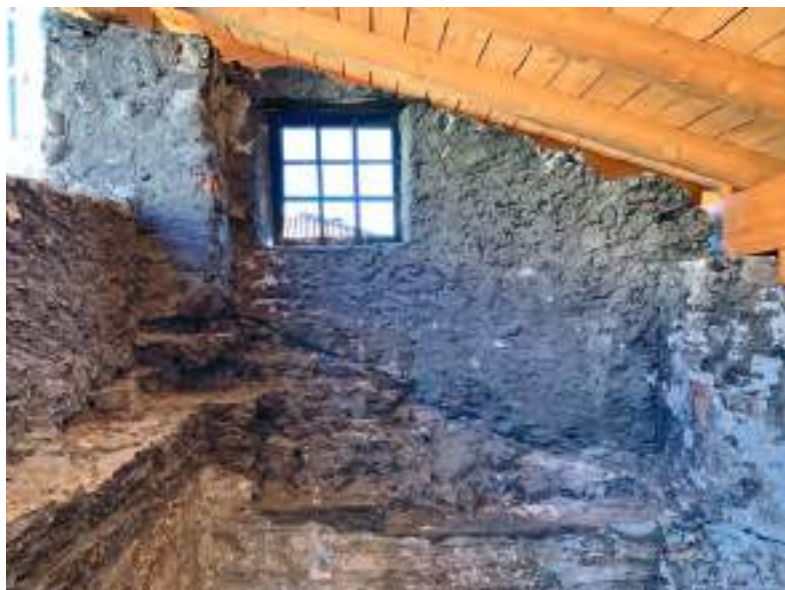
Fig. 21. Trento, Torre Bellesini. Risega muraria e sopraelevazione tarda.
