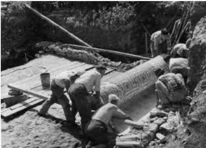
Fig. 4. Trento, via A. Rosmini. Operazione di stacco del mosaico; si noti sulla sinistra l'uso della lama per agevolare il distacco della superficie musiva.
