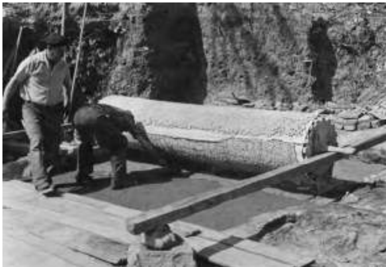
Fig. 6. Trento, via A. Rosmini. Operazione di ricollocazione in situ del mosaico con l'impiego del rullo.
