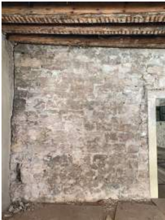
Fig. 19. Trento, Torre Bellesini. Prospetto esterno verso nord, livello 2.
