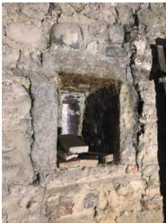
Fig. 18. Trento, Torre Bellesini. Vista interna feritoia da arciera EA31, livello 1.
