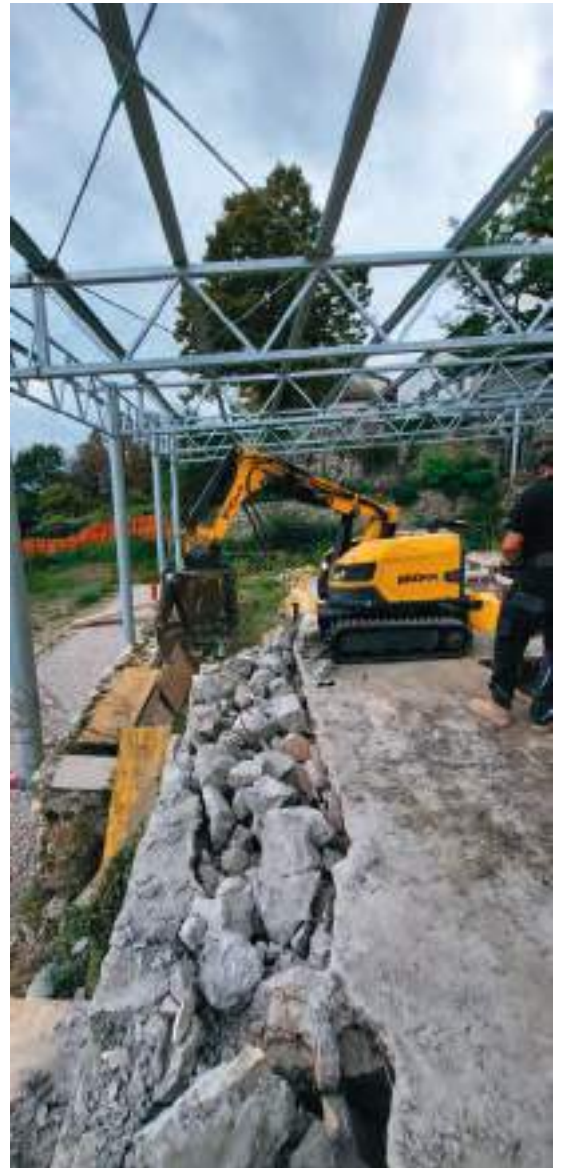
Fig. 2. Isera, villa romana. Demolizione delle strutture in cemento tramite ragno radiocomandato dotato di pinza idraulica.
