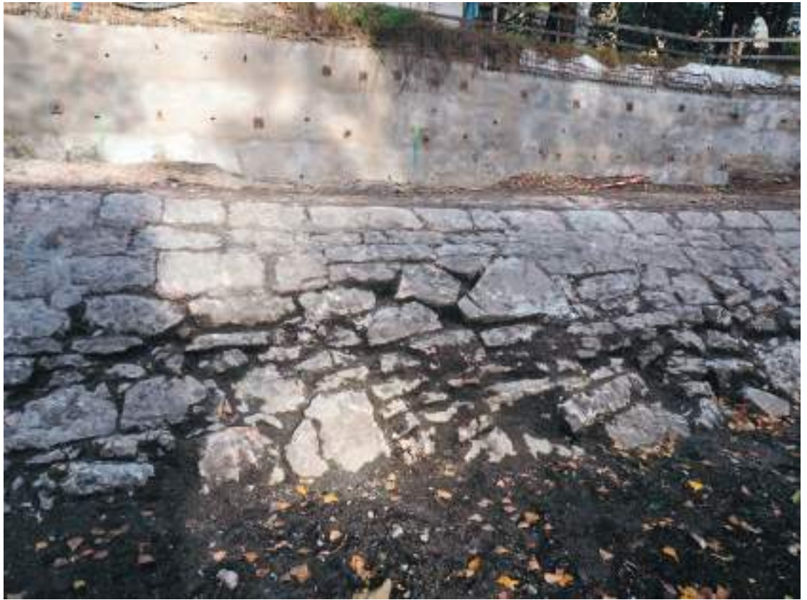
Fig. 5. Trento, piazza Centa. Particolare del rivestimento in lastre di pietra delle sponde della piscina.
